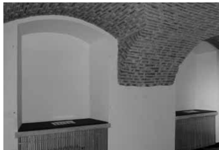
Poudarjeno fugiranje obokov v prostorih občasnega razstavišča v pritličju (foto Dušan Kramberger, 2013).
