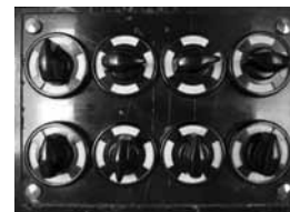
Električna stikala v kamniti špaletih prehoda med razstavnimi prostori (foto Dušan Kramberger, 2013).
