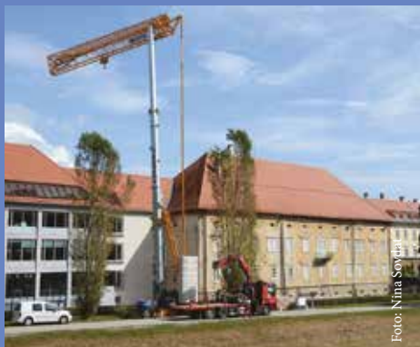
Pričela so se gradbena dela za postavitev dvigala v Stari grofiji, ki bo omogočil dostop v vse etaže grofije tudi gibalno oviranim obiskovalcem.
